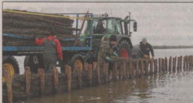
Eine Holz Bühne mit Strukturen soll das Ufer vor Wellen- und Eisgang schützen. • Fotos: Naturschutzring Dümmmer
